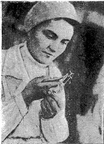
На заводе «Радиолампа» (Щелковский р-н Московской области). Бригадир сборочного цеха т. Пыльнова за монтажом ножек одной из наиболее распространенных ламп—СО-118
